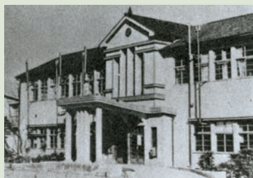
三期目の庁舎 (昭和24年～昭和48年)
